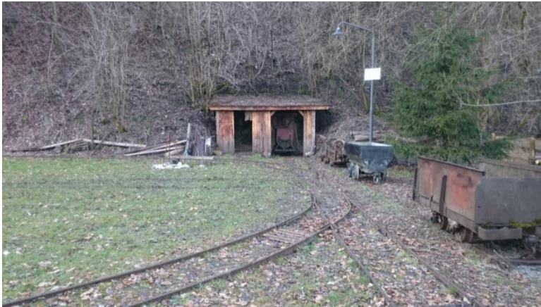
Abb.3: Blick auf einen Stolleneingang (Eigenaufnahme)
