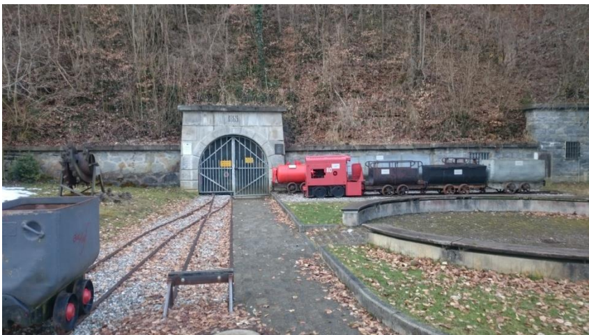
Abb.2: eigene Aufnahme des Eingangs zum Schaustollen
